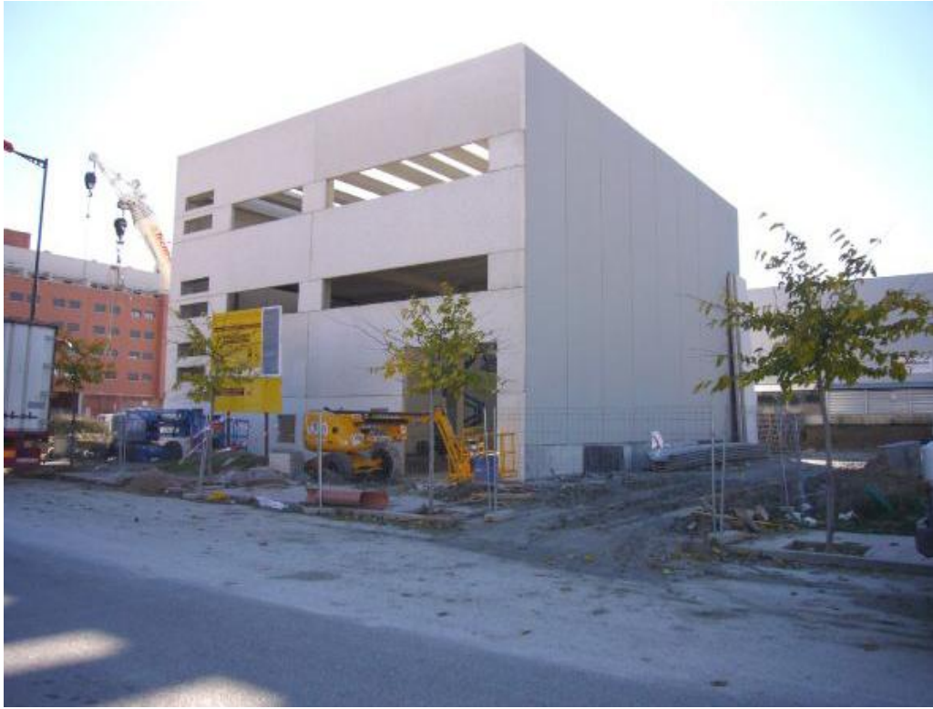
El Proyecto en construcción en los primeros meses de 2007
