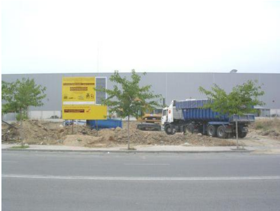
Comienzan los movimientos de tierras hacia finales de septiembre de 2006
