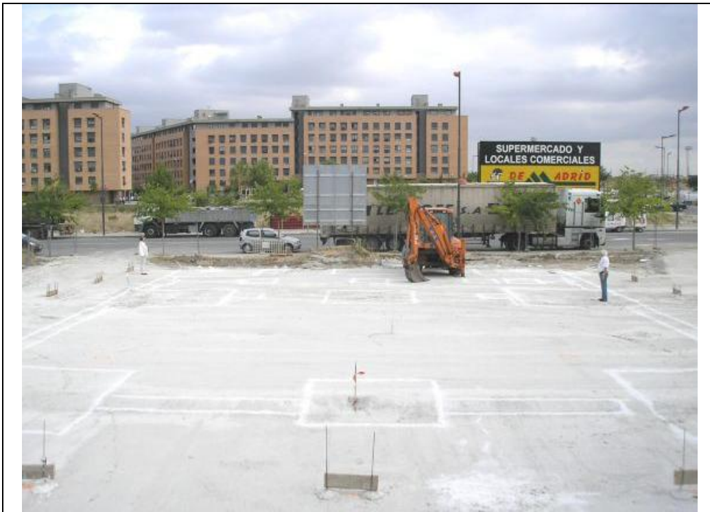
Cimentación terminada. Replanteamiento de la base de la estructura de la Nave.
