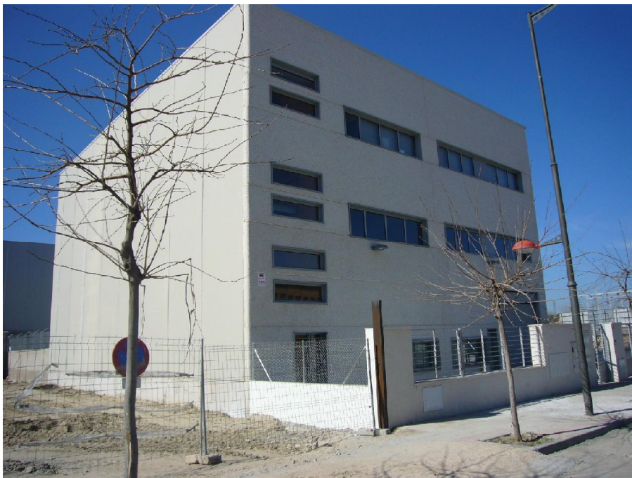
El Proyecto ya terminado (febrero 2008) antes de la inauguración
