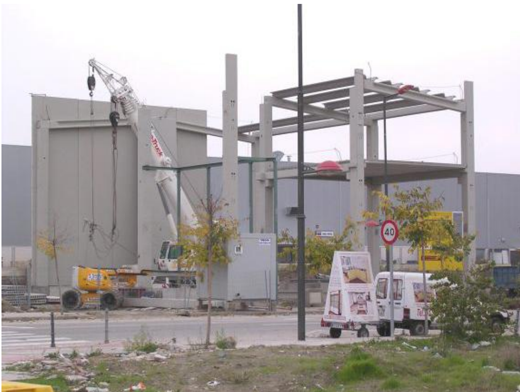
Montaje de la estructura e instalación de paneles prefabricados de cerramiento (diciembre de 2006).
